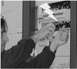
ESEGUIRE INSTALLAZIONI, CABLAGGI E ALLACCIAMENTI DI IMPIANTI
